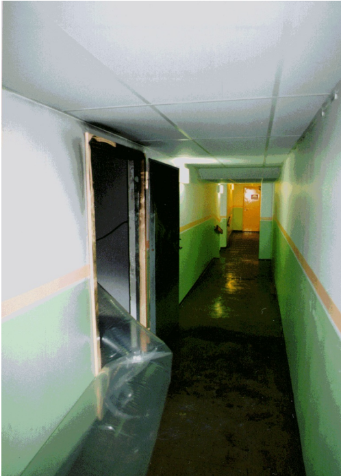
Källarkorridoren utanför soprummet.
