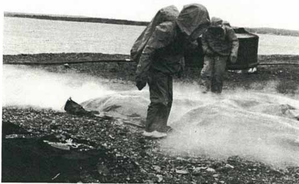
Tätning av presenningskant
