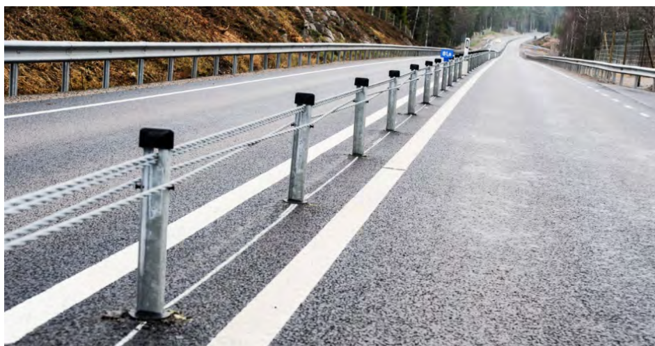
Bild 16. Räckestyp där några av vajrarna är flätade runt stolparna. Foto: ATA AB
