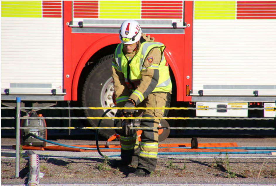
Bild 20. Kapning av utspänt vajerräcke. Endast den som kapar ska befinna sig nära räcknet.
