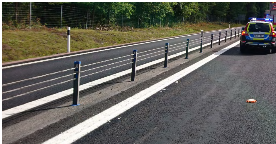
Bild 15. Räckestyp där alla vajrar ligger i en slits i mitten av stolparna.
