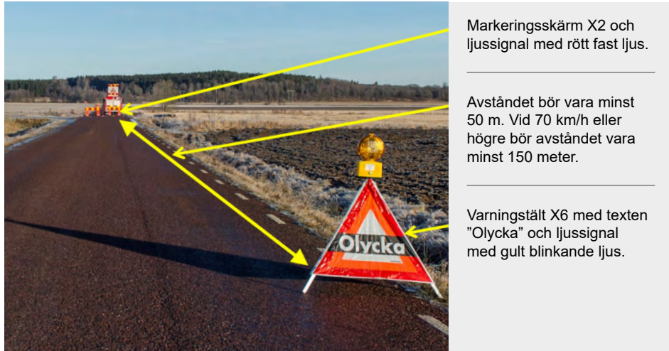
Bild 2. Exempel på utmärkning av helt avstängd väg. Foto: David Hårseth.
