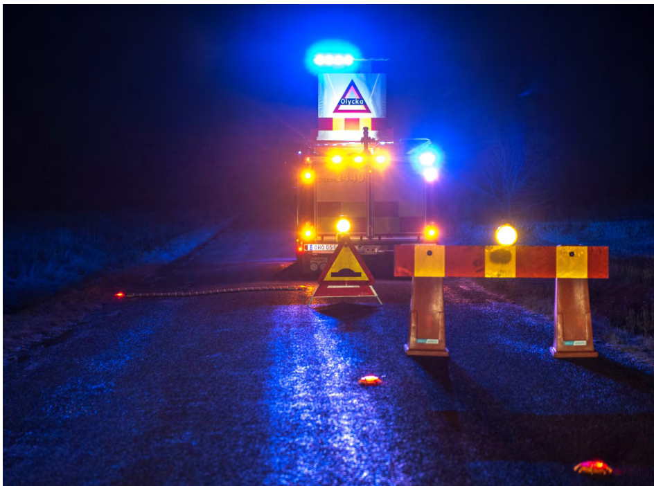
Bild 8. Exempel på utmärkning av delvis avstängd väg i mörker. Foto: David Hårseth
