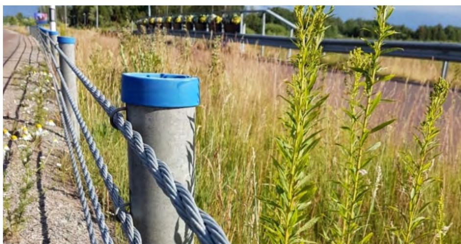
Bild 17. Räckestyp med alla vajrar på ena sidan av stolparna.
