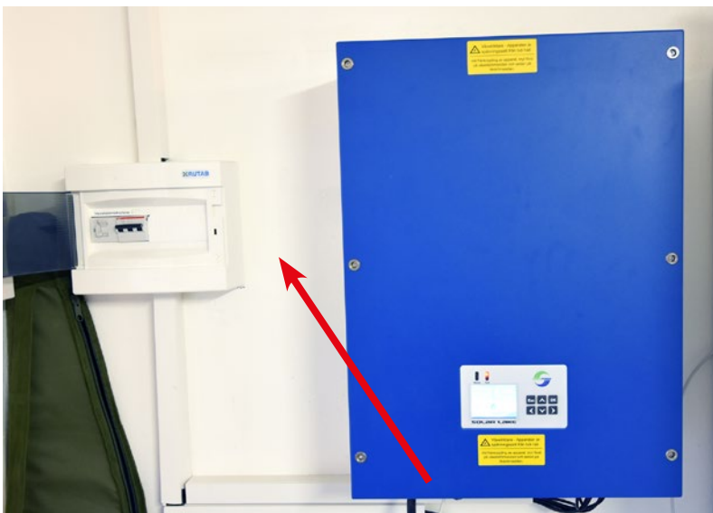
En blå växelriktare. Strömbrytaren är markerad med en röd pil.
