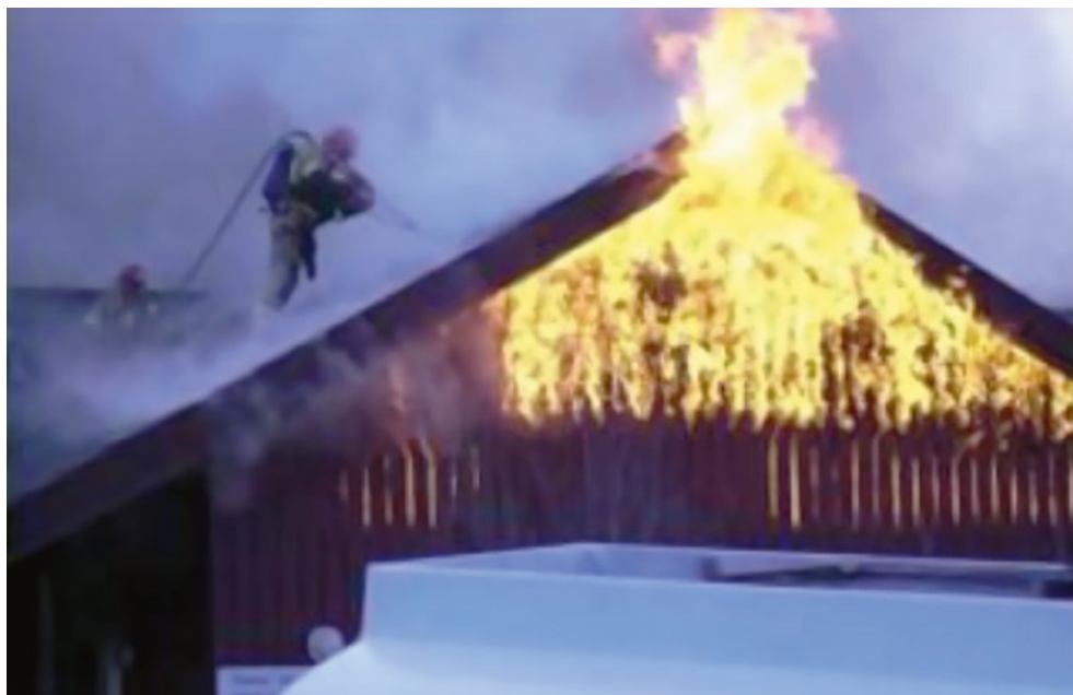
Figur 7. Skärsläckare används mot en takbrand. Den lyckas dämpa förloppet kraftigt en kort stund efter att bilden är tagen.
