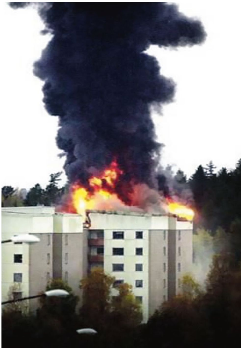
Figur 3. Vindsbrand i flervåningshus i Borås. Bild: Borås Tidning.
