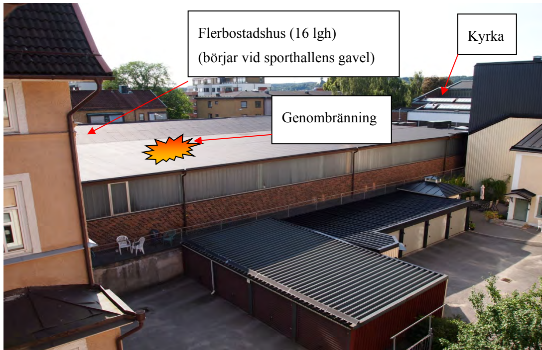
Figur 21 Bild från baksidan av byggnaden mot innergården. (Foto: SÄRF).
