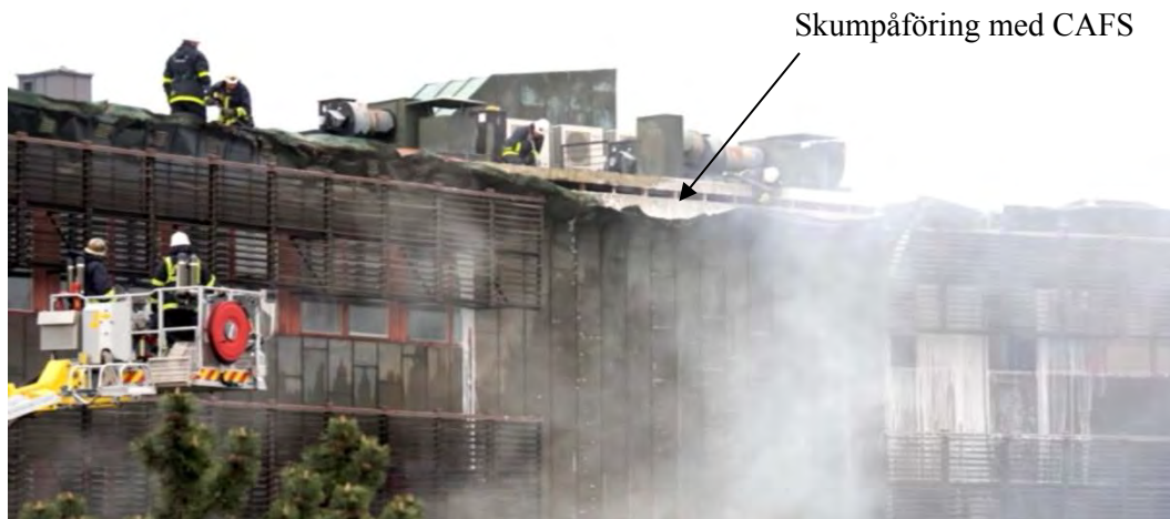
Figur 13 En bild över arbetet som genomfördes på högdelen med att fylla insidan av fasaden med CAFS. (Foto: MSB 90 sekunder).
