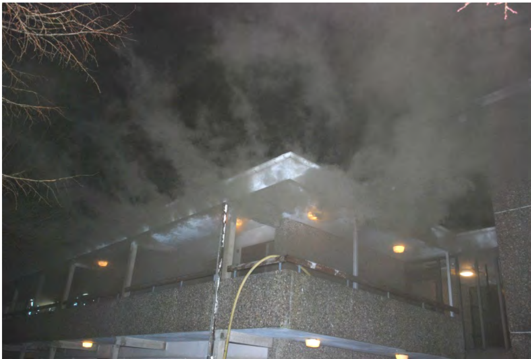
Figur 11 Rökspridning från takfoten över byggnadens loftgångar. (Foto: Räddningstjänsten Storgöteborg).
