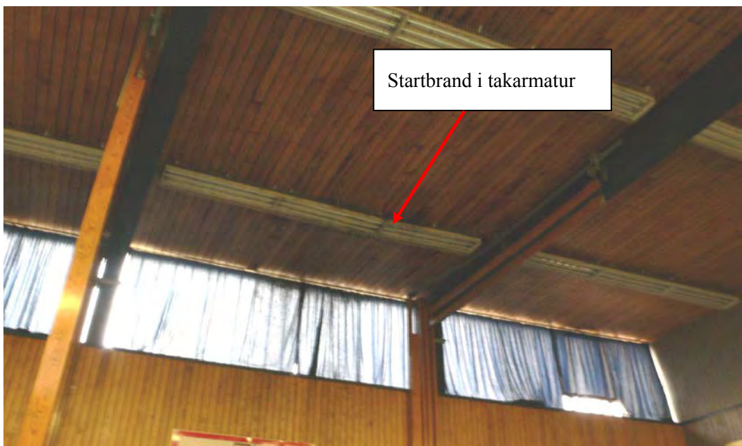
Figur 20 Innertaket i idrottshallen och den takarmatur där branden startade. (Foto: SÄRF).
