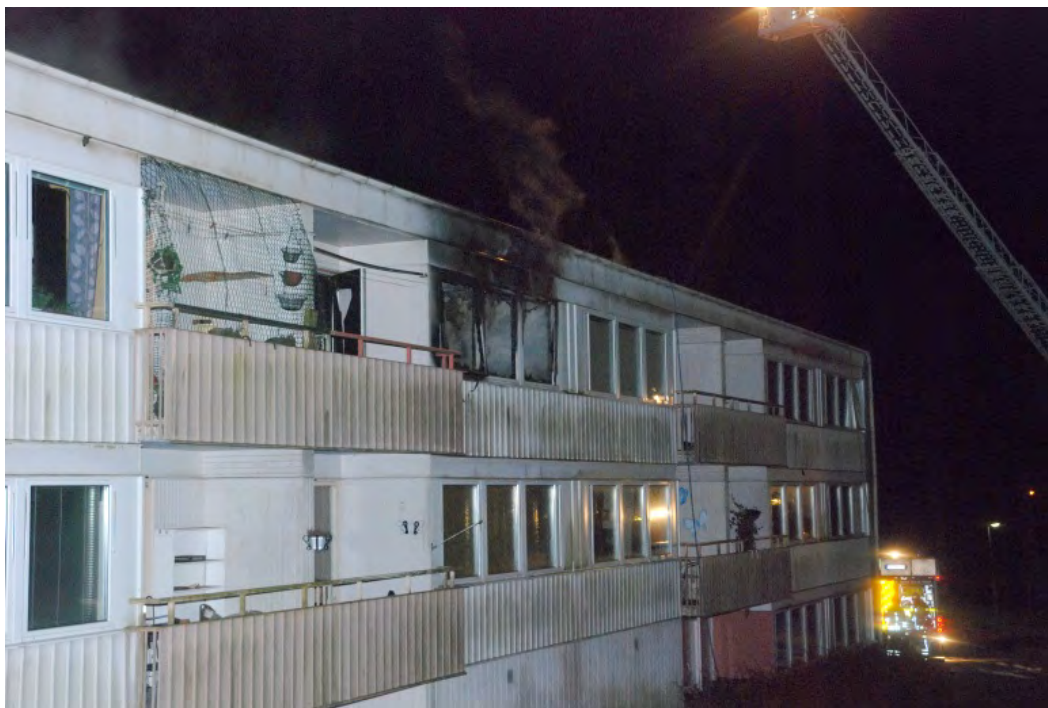
Figur 10 Genombrunna fönster och rökspridning via simsventilen. (Foto: Räddningstjänsten Storgöteborg).
