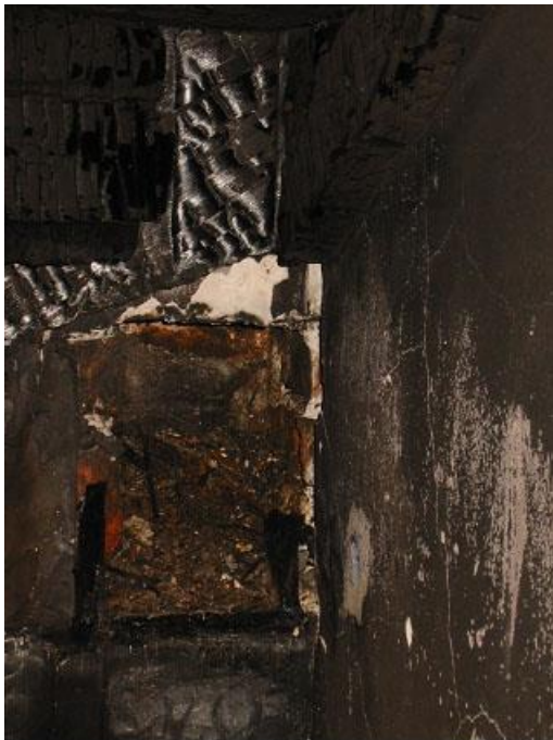
Foto 6. Ovanför toalettstolen har ventilationen varit. Från väggen till rensluckan har en trtrumma monterats (ca 1 m)
