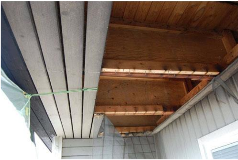
Bild 12. Bilden visar glespanelen i taket ovanför balkongerna. Bilden är tagen på M-vägen 84 mot M-vägen 86.
