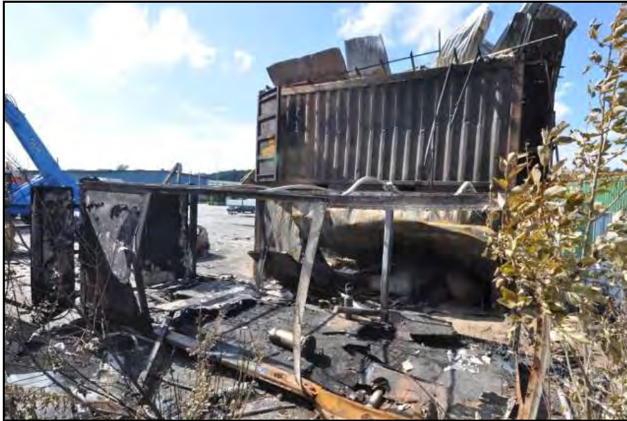
Bild 7: Förrådscontainern i förgrund och tillverkningscontainern bakom. Här syns tydligt hur tillverkningscontainerns långsida tryckts in.
