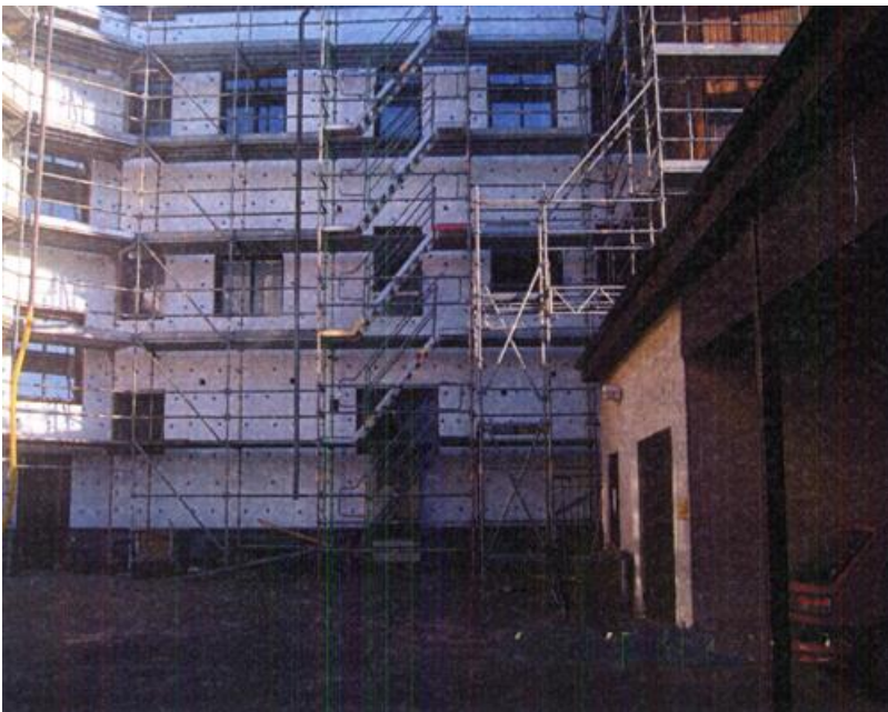
Restaurang mot innergården.
