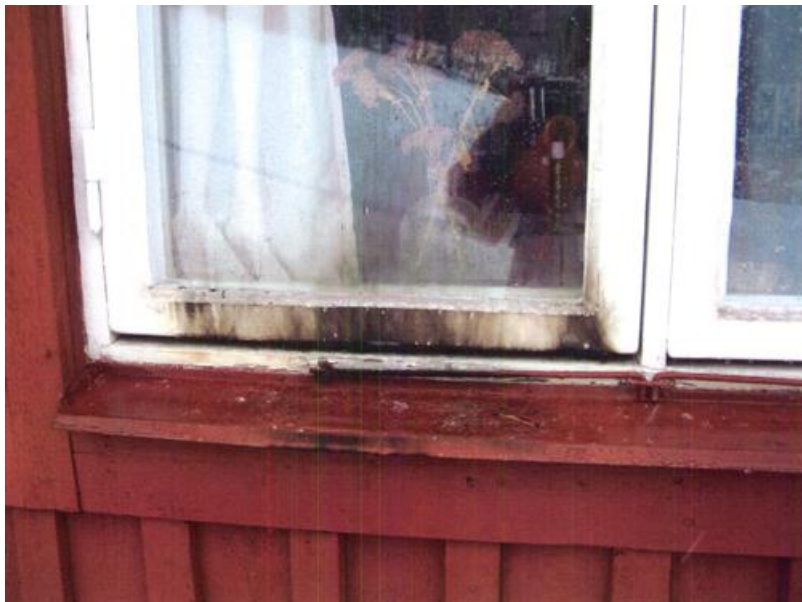
Fönster på gaveln, försök att anlägga brand.
