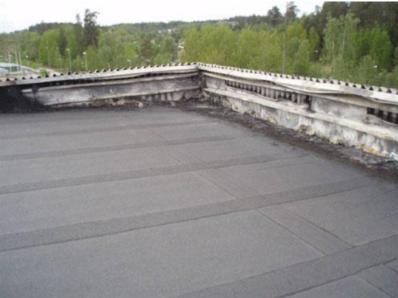
Bild 5: Brandskada tak
