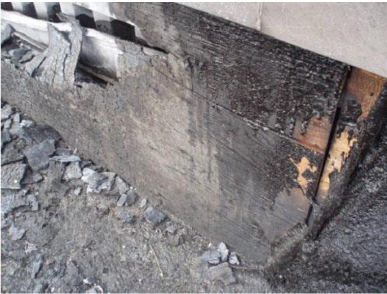
Bild 7: Vägghkonstruktion med byggplyfa samt tjärpapp.
