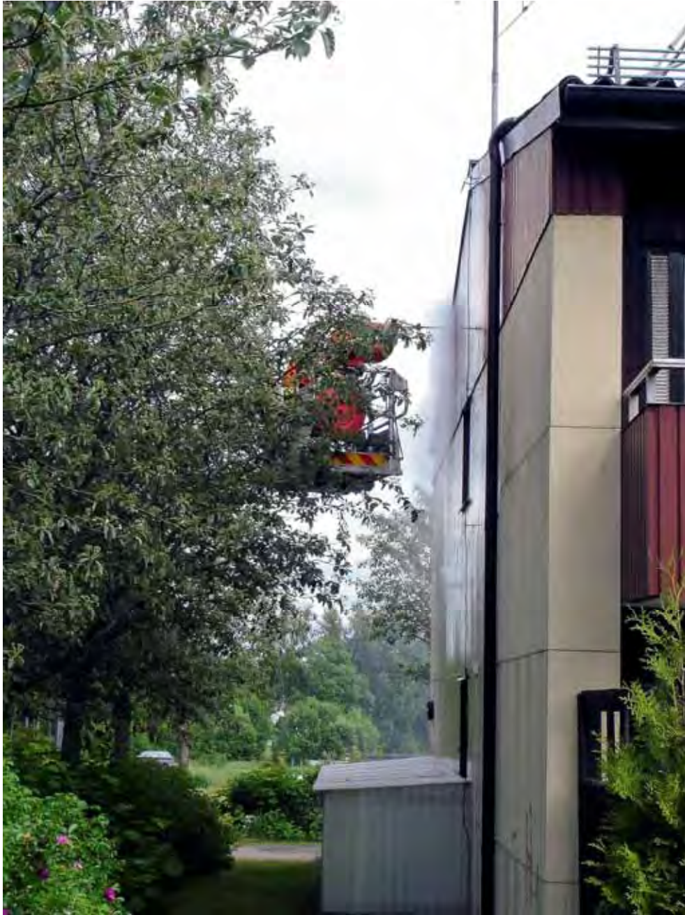
Bild 1 Arbete med skärsläckare
