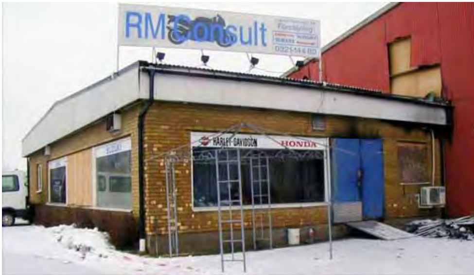
Bild 7 visar brandlokalen. I bakgrunden syns den röda byggnaden som används som lager för trävaror
