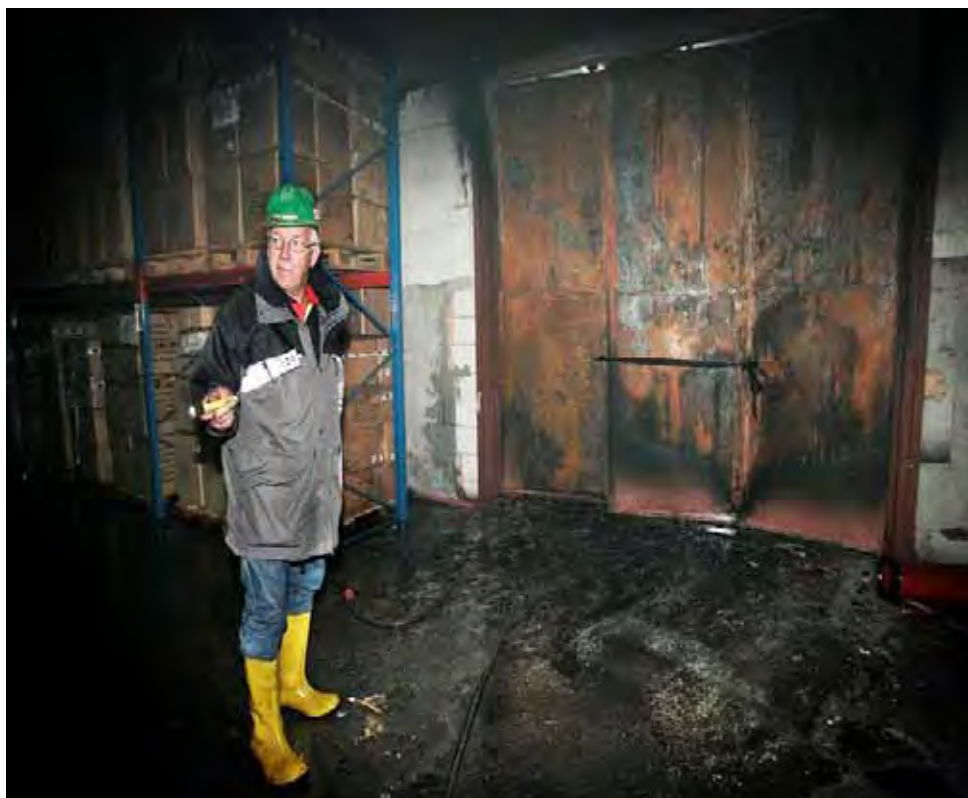
Bild 11 från lagerlokal intill brandrummet
