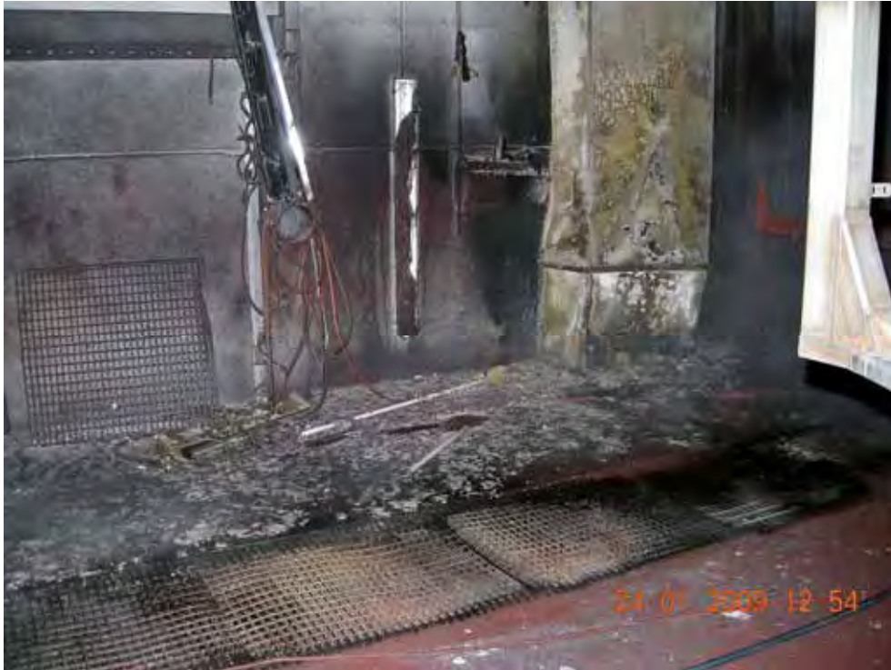
Bild 5 visar var branden startade och den kanal där branden spred sig upp till ventilationssystemet.
