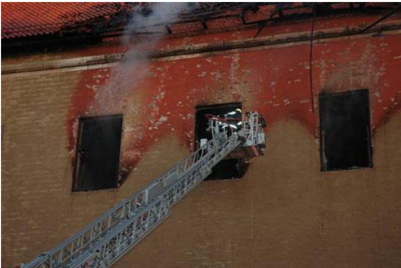
Uppställd brandtekniskt klassad dörr med kabeldragning genom dörrhålet vilket gör att dörren inte kan stängas
