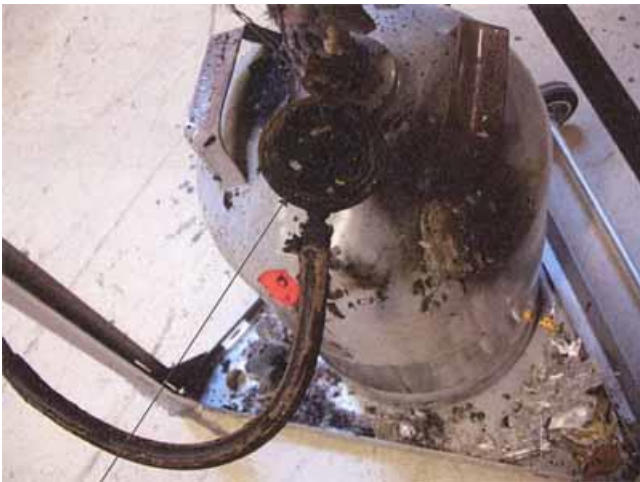
Reduceringsventilen. Övre delen är borta.
