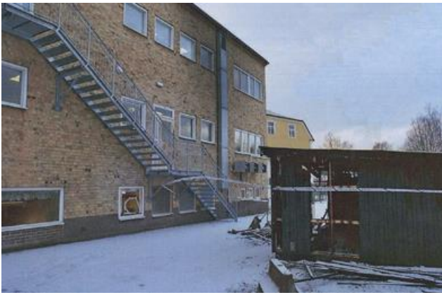
Sopstation till höger.
