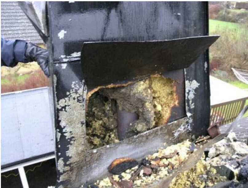
Skorstenen med enkel matta runt rökröret och fylld med lösull
