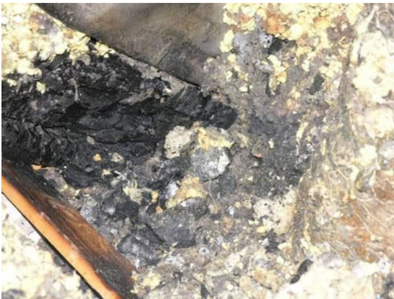
Närbild på takstolen. Träregeln som syns till vänster har knappt inga brandskador
