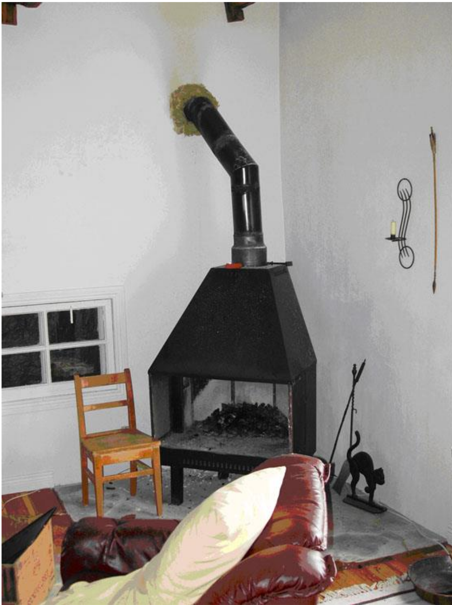
Eldstaden med dess vägg-genomföring. En svag sotbild syns på väggen ovanför rökröret.
