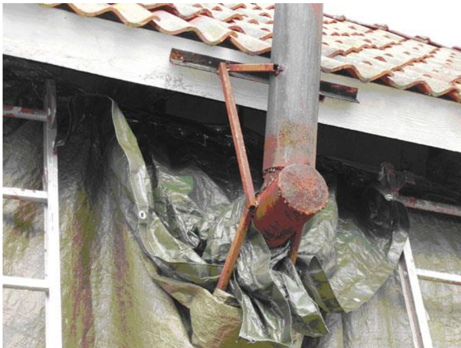
Är sotning möjlig i denna konstruktion
