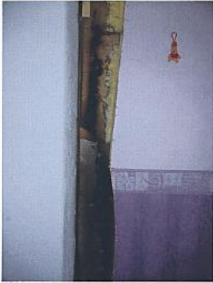
Rummet bakom ugnen, väggen uppsågad.
