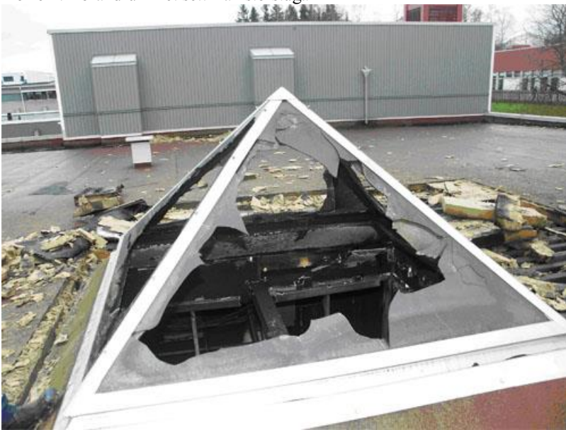
Lanternin ovanför brandrummet.
