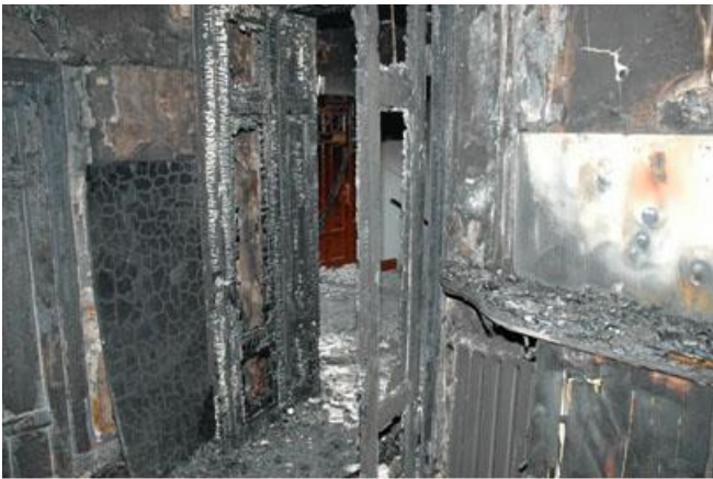
Fotot taget inifrån hallen och ut mot trapphuset.
