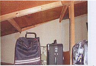
Här är det dubbelgips, men passningen är si och så.
