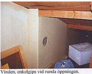
Vinden, enkelgips vid runda öppningen.
