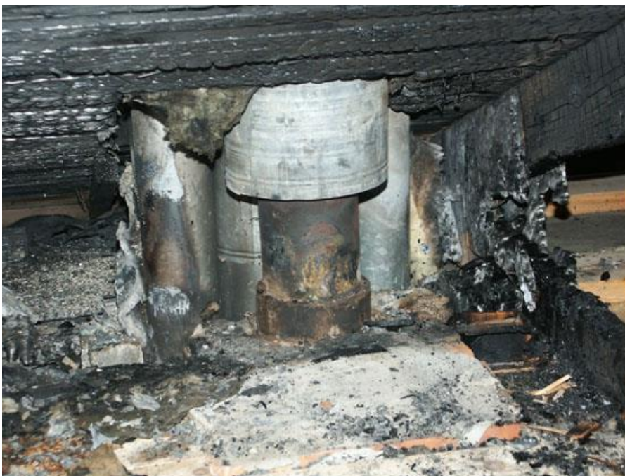
Närbild på primärområdet. Pipan närmast kameran går från kaminen.
