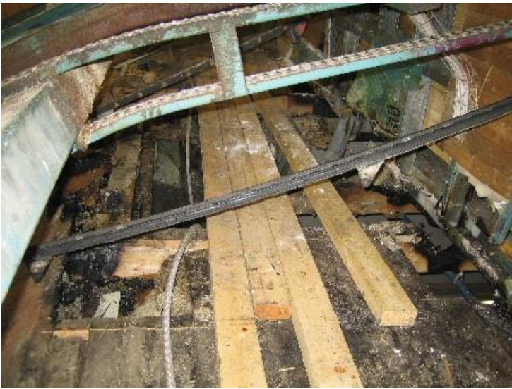
På bilden syns de avbrända balkarna.
