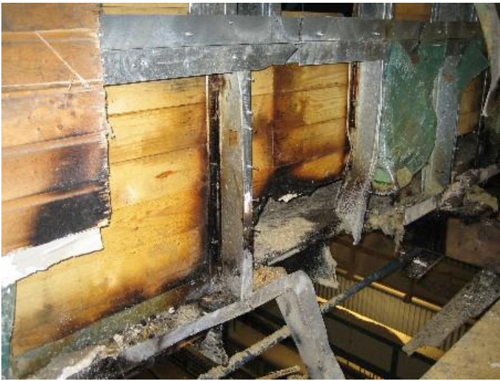
På bilden syns de avbrända balkarna.
