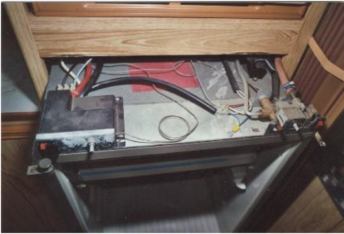
Översidan på kylskåpet med reglage för tändning av gasol samt 220V anslutning.
