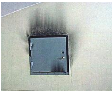
Lucka mellan krypvinden och trapphuset.
