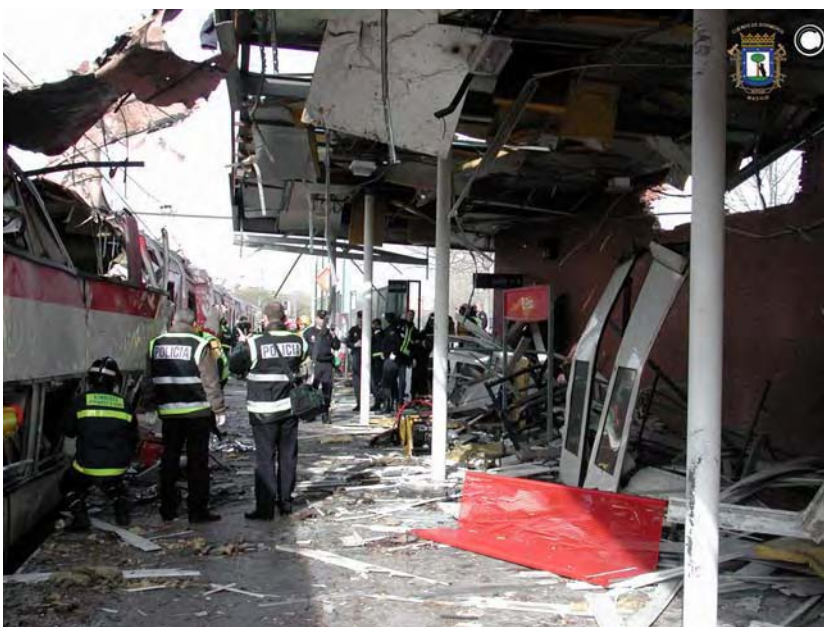
Omfattande tryck- och splitterskador vid El Pozo. Bild: Räddningstjänsten Madrid.
