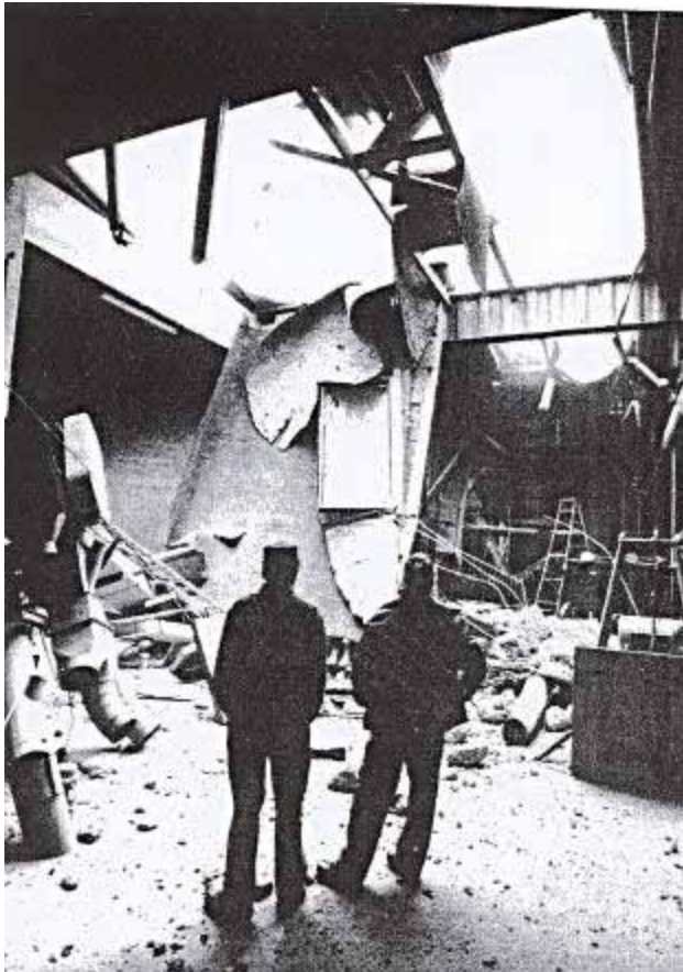
Figur 9 Följderna av en dammexplosion i en silo hos Lantmännen i Västerås. 90 m 2 av yttertakets ovanför silorna revs upp och stora betongblock landade på gården, lyckligtvis utan att någon kom till skada (Lars Höglund/VLT-bild)
