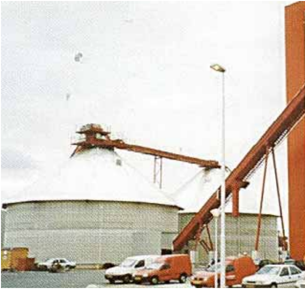
Figur 3 Silor för bränslehantering (Raumaster OY)
