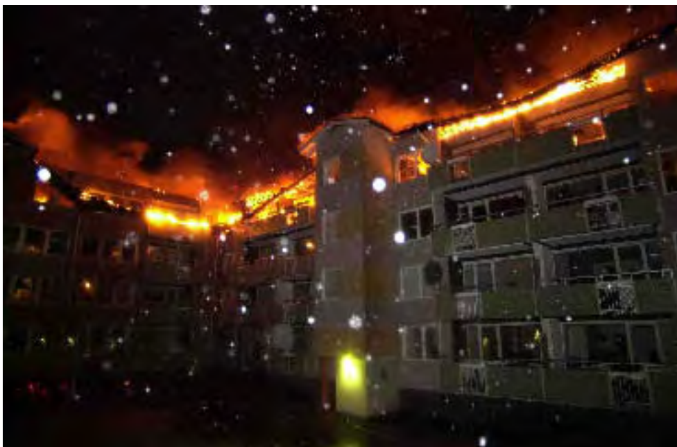
Bild 15 Brandtrycket pressar ut brandgaser som kan sprida sig sidledes under takfoten
