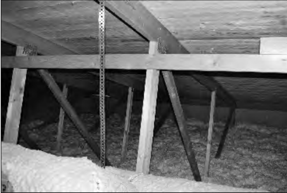
Bild 4 Ventilationsupphängning direkt i takstolarna
