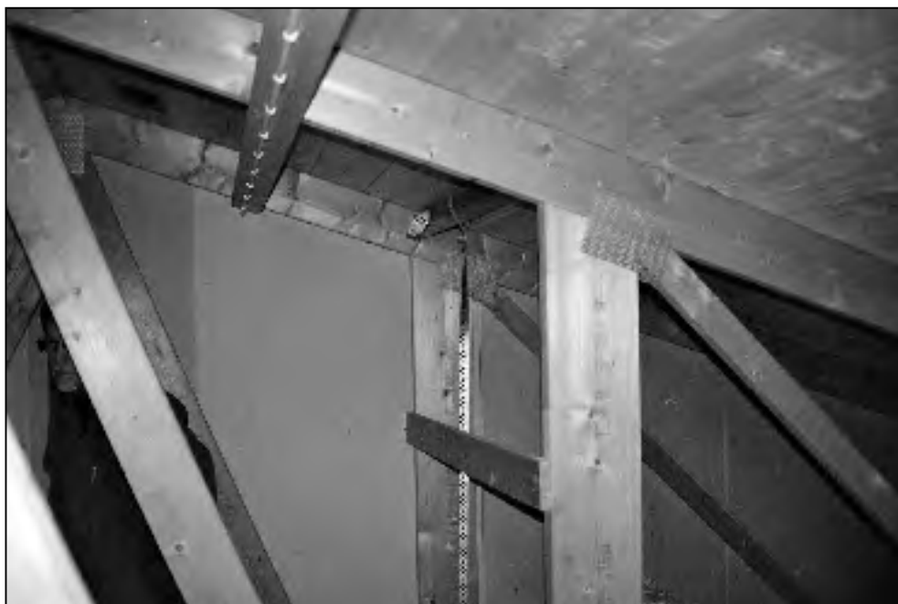
Bild 2 Takstol sammanhållen av spikplåtar
