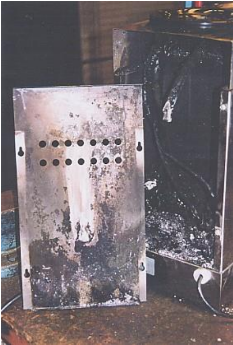
Baksidan med täckplåten bortskruvad.
