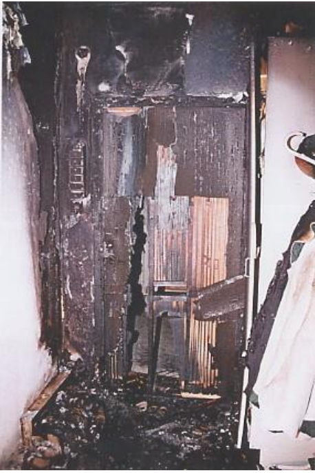
Hallen med lägenhetsdörren stängd.
