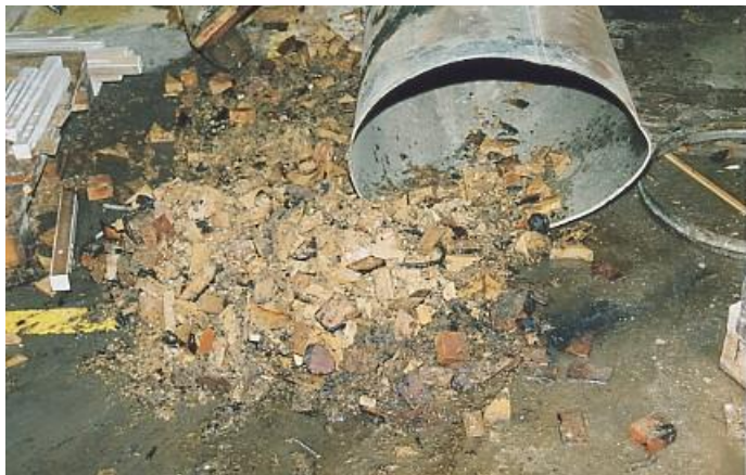
Exempel på innehåll i ventilationskanaler.
