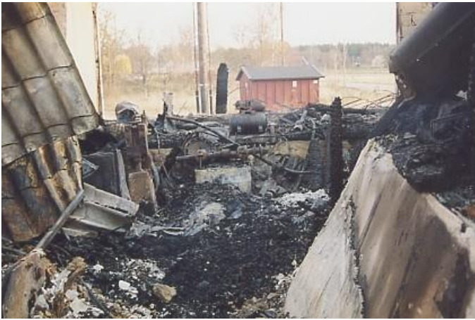
Primärhård efter grovröjning, pannrum till höger.
