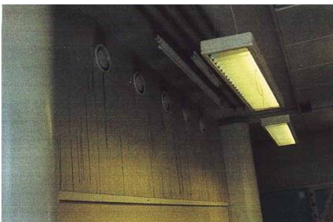
Rökspridning skedde bl a genom frånluftskanalerna.
