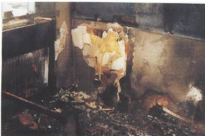
Här stod soffan där branden anlades.
