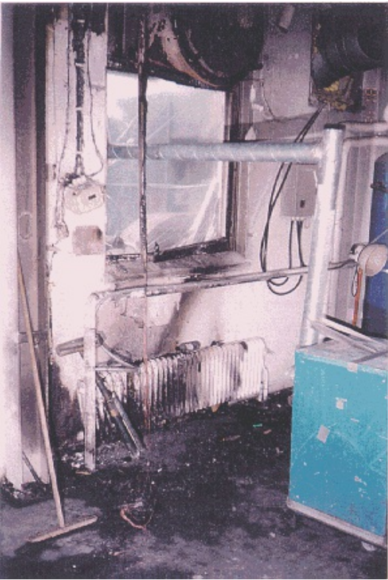
Brandplatsen. Brandhärden syns nere på golvet. Det "vita" på väggen är ej på grund av hettan, utan är helt opåverkad målarfärg. I taket ovan satt lysröret. På golvet fanns kartonger och diverse virke samt en hisskorg.
