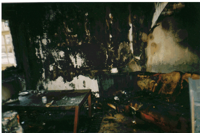
Branden startade i vinklesoffan vars ena del helt brunnit bort.
