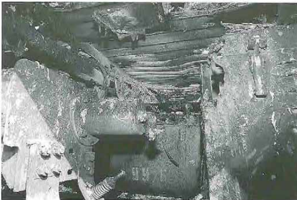
Oskadad och skadade detaljer av el- och tryckluftinstallationen.
