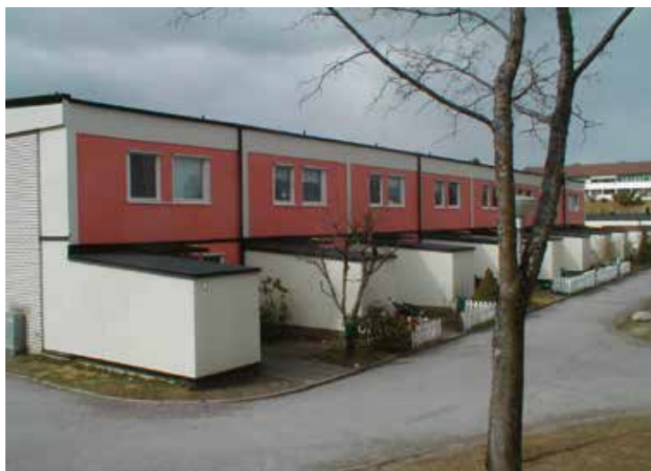
Radhus byggt enligt SBN 80.
