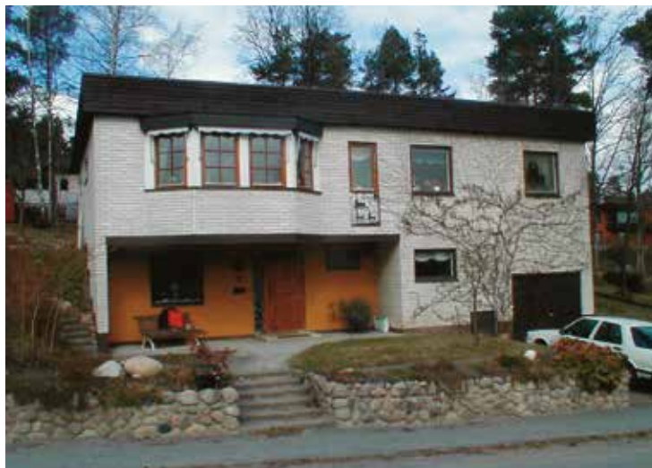
Villa byggd enligt SBN 67. Två plan, byggnadsarea 100 m 2 , sammanbyggt garage.
