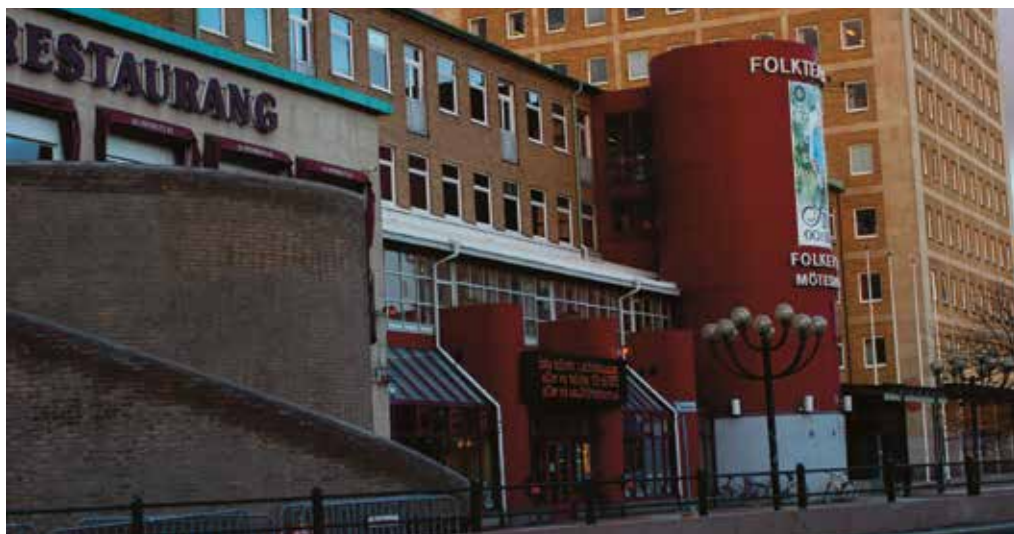
Diskotek byggt enligt SBN 1975.
