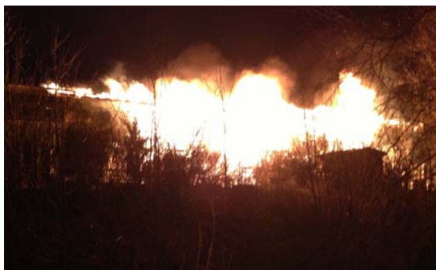
Bild 14. Klockan 00:55. Foto taget av boende från baksidan av radhuslänga 1. Bilden visar tydligt brand-spridning längsmed hela takfoten och fasaden.
