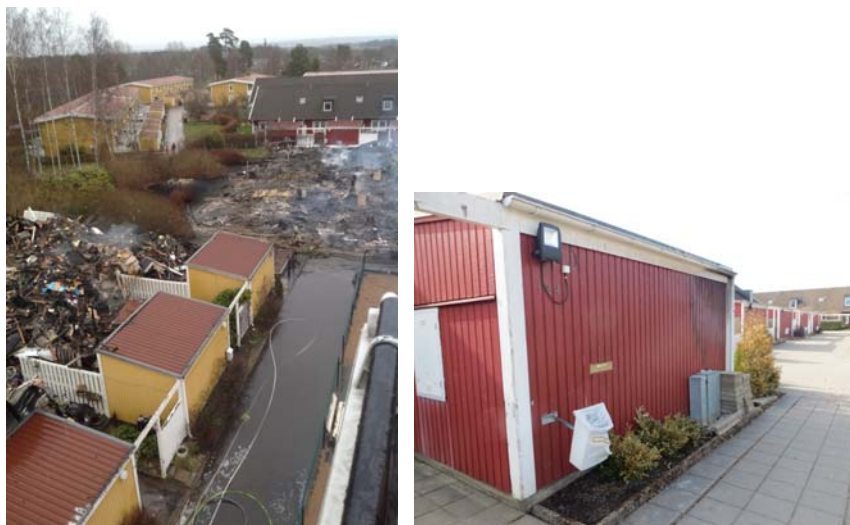
Bild 32. Två radhuslängor totalförstördes i branden. Intilliggande byggnader fick bland annat skador på fasad, brevlådor och fönster. Foton tagna av räddningstjänsten och olycksutredarna.
