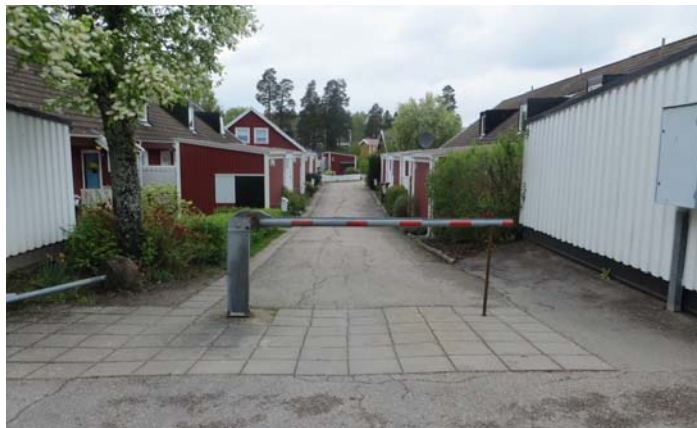
Bild 27. Bommen var förankrad mitt i gång-/vägbanan, vilket begränsade vägens bredd även med bommen i uppfällt läge.
