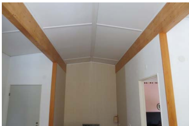
Bild 8. Radhusen hade brandavskiljande väggar (B30) upp till tak (ingen krypvind).
