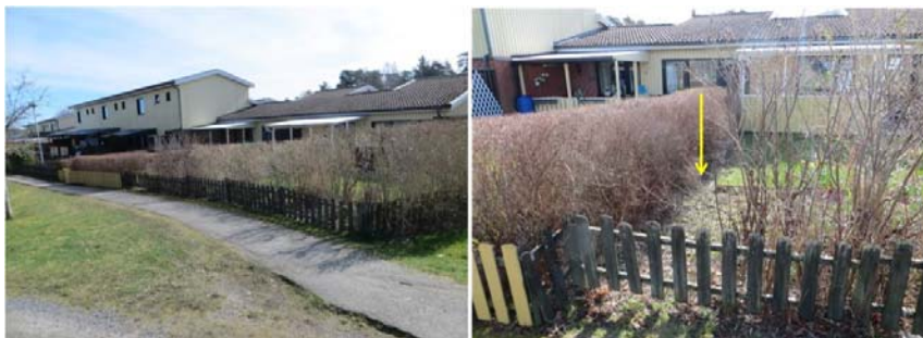
Bild 28. Bilden till vänster visar att brandpostflagga, som markerar brand post, saknas. Gul pil markerar brandposten, belägen inne i en trädgård.
