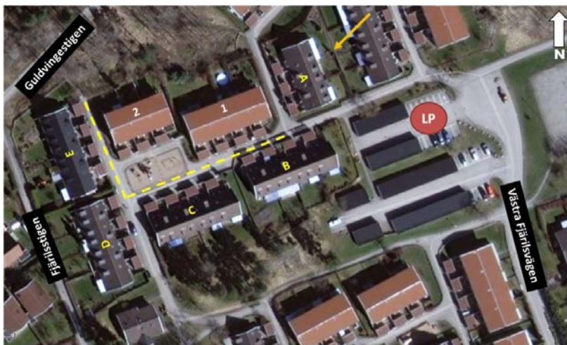
Bild 25. Målet med insatsen var att förhindra branden från att sprida sig till andra byggnader än radhuslänga 1 och 2. Gul streckad linje visar beslutade begränsningslinjer.
