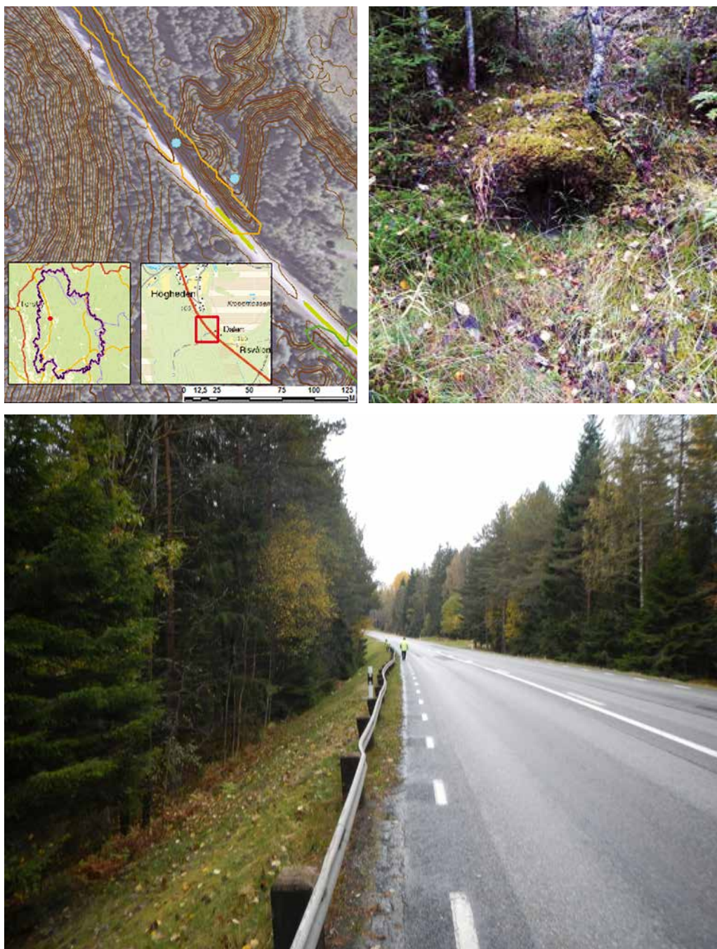
Figur 35. Område med indikation på vägbank > 10 m i sluttning (orange) samt indikation på vägtrumma. Vägtrumman var mycket svår att upptäcka, längst ner i slänten, men var öppen ända till andra sidan vägen för man kunde se ljuset på andra sidan tunneln. Nedre bilden visar den branta vägbanken i sluttning och hur räcket indikerar vissa sättningar.
