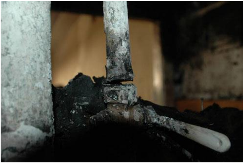
Gasledningen kapad här med vinkelslip
