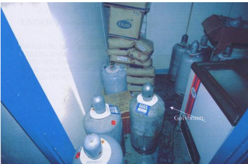
Gasolflaskorna som förvarades i källarförrådet till restaurangen, och som ansluter till lastgatan för köpcentret. Bilden talar sitt tydliga språk om förvaring.
