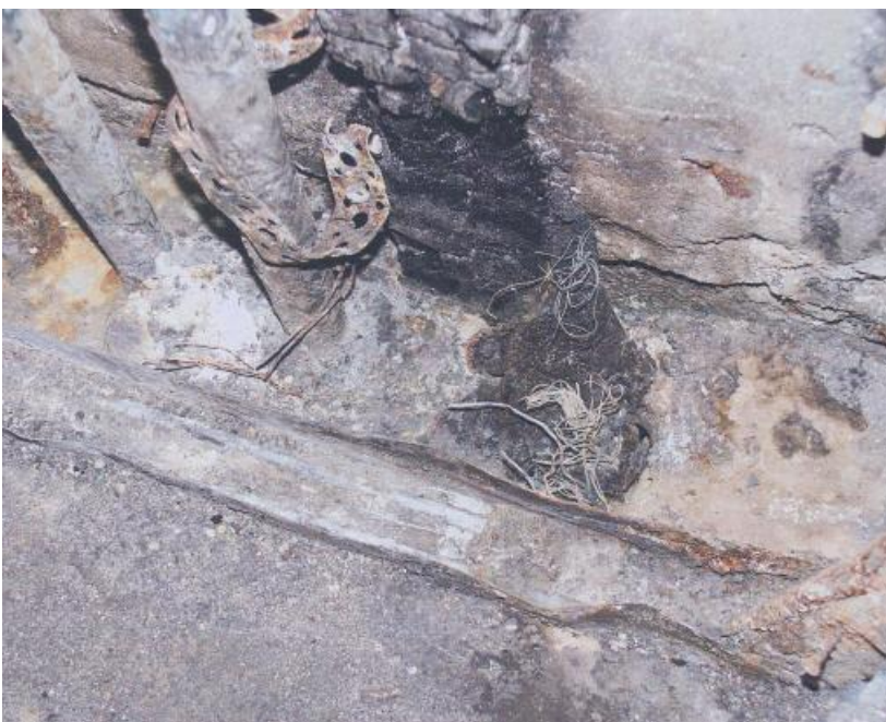
Bild 8. Hålet för inkommande kabel efter att kabeln har avlägsnat.
