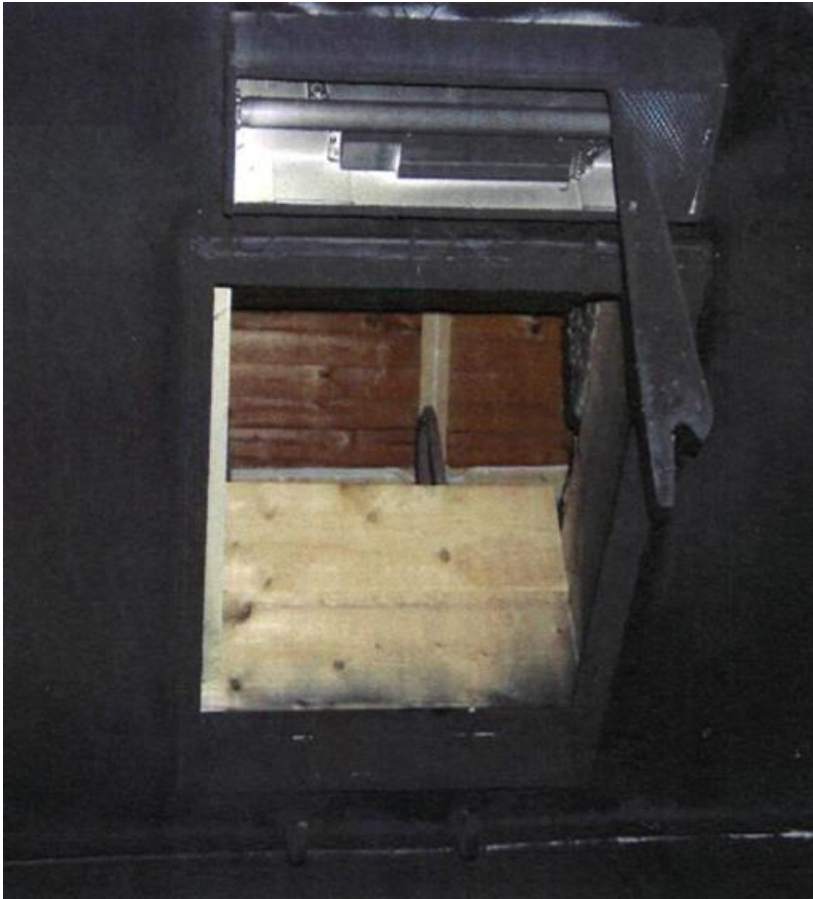
Lucka upp till vinden.
