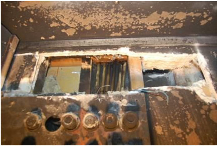
Rök- och sotspridning i brandcellsavskiljande vägg EI60
