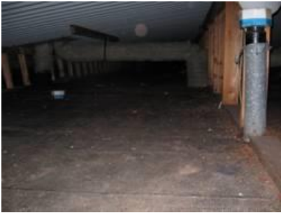
Plåttak på takstol av trä, osektionerad vind, gamla takets tjärpapp
