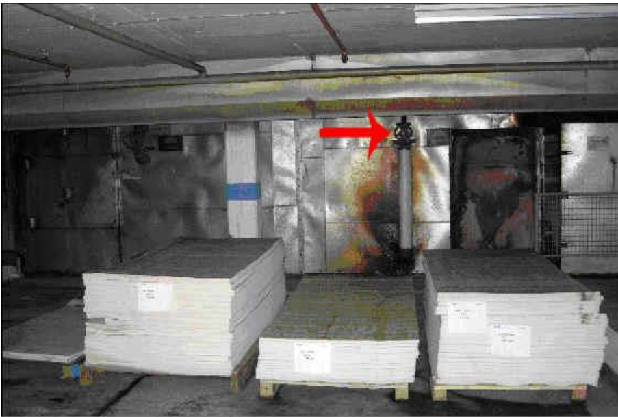
utsidan på torkugnen, framför latexmadrassstillverkning som är klara. Vid pilen kran för ångsprinkler.
