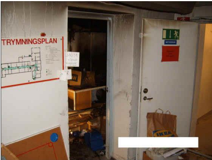
Uppställda dörrar i källare.
