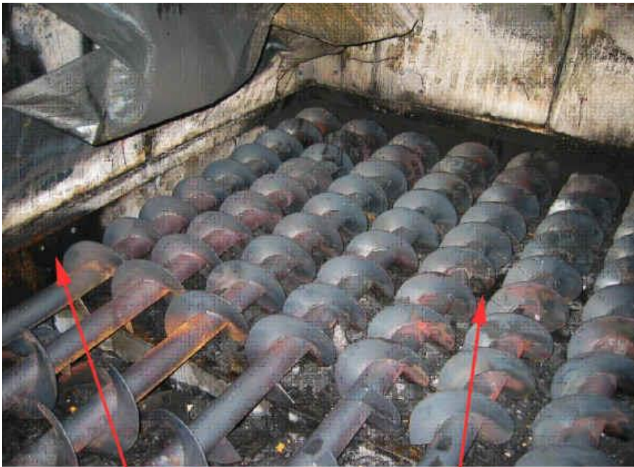
Kulvert in till fabriken
