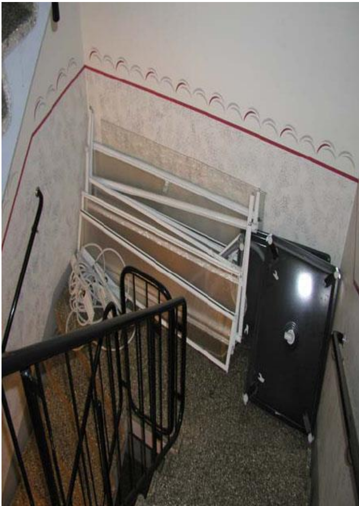
Belamring som försvårat utrymningen
