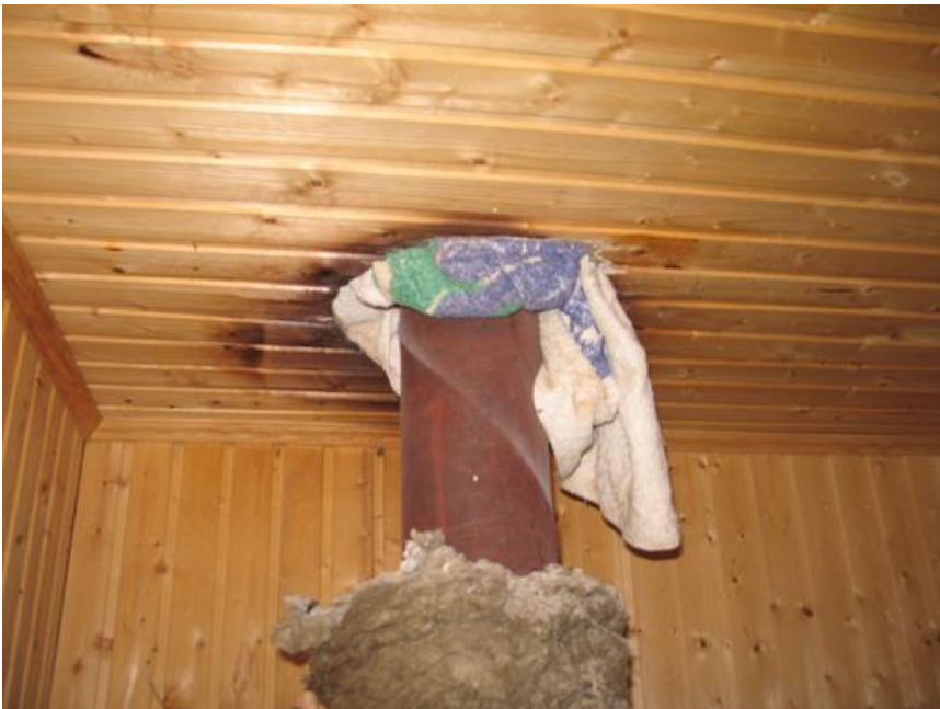
Avståndet mellan basturöret och träpanelen var 7 centimeter.
